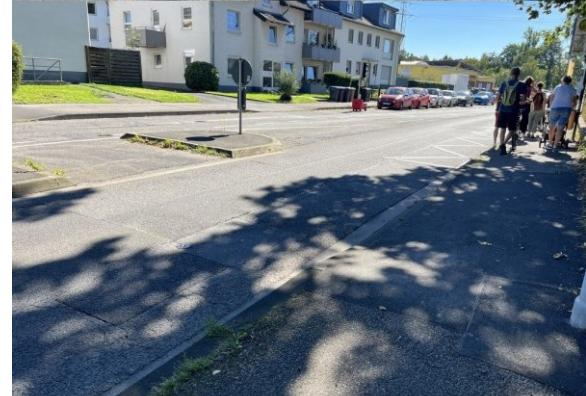
Die vorhandene Querungsstelle ist mit einer Nullabsenkung ausgestattet, jedoch fehlen die taktilen Leitsysteme und eine Tastkante für Menschen mit Sehbehinderung. Diese Querungshilfe ist zum Erreichen der Bushaltestelle relevant, der Fußverkehr hat an dieser Querung mit Mittelinsel jedoch keinen Vorrang.
