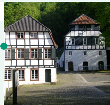
Fachwerkhäuser der Papiermühle Alte Dombach
