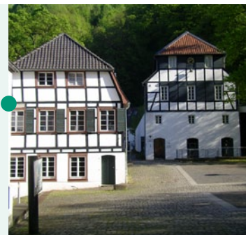
Les maisons à colombage dans le « Bergischen Land »
