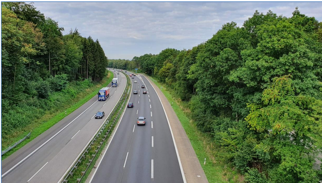
Abb. 12: BAB 4 (Köln-Olpe), die nördlich des FFH-Gebietes „Königsforst“ (links) verläuft, in der rechtsseitigen Bildhälfte lässt sich durch die L 136 erkennen, die hier, getrennt durch einen Gehölzstreifen, parallel zur BAB 4 verläuft (Foto: ILP 2020).
