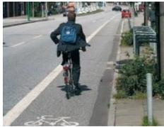
**Radfahrstreifen** mit durchgezogener Linie markierte Fläche auf der Fahrbahn. Darf von Kraftfahrzeugen nur beim Ein- / Abbiegen überquert werden oder um zu einem Parkstand zu gelangen. Breite mindestens 1,85m.
