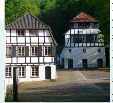
Fachwerkhäuser der Papiermühle Alte Dombach
