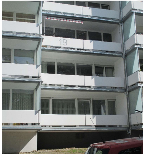
Abbildung 12 - Beispiel Hausnummernkennzeichnung auf der Gebäuderückseite im 2.OG
