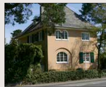
Beamtenwohnhaus (um 1900), Umbau 1934, vorbildlich saniert, Richard-Zanders-Str. 53
