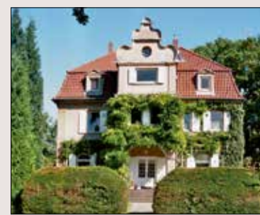
„Villa Bopp“ v. L. Bopp zum Eigenbedarf (um 1910), 3000 m 2 Grund, Elemente aus Barock und Jugendstil, Talweg 3
